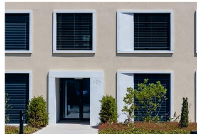
**Die attraktiven Fensterumrandungen aus Glasfaserbeton beim Baufeld E verleihen dem Gebäude eine edle Note.**
